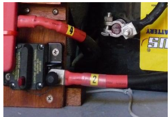
Bild: Kennzeichnung mit selbstklebenden Etiketten oder Nummern
