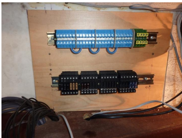
Bild: die Grundplatte mit den Hutschienen wird installiert
